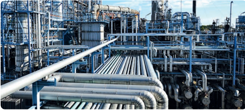
UMSCHLAG Industrielle Öl- und Gasinstallation COVER Industrial oil and gas installation
